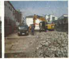
6月に工場の解体が着工された
