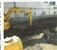
14年1月化学酸化剤攪拌混合浄化工事
