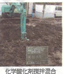
化学酸化剤攪拌混合
