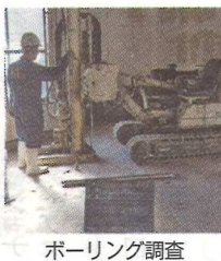
ボーリング調査
