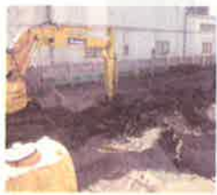
草加 JP 浄化工事
