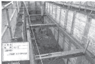
プレス工場跡地の浄化工事の様相
